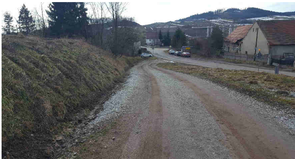
zdj. 2 Istniejąca droga w m. Gostków dz. 456 – rów prawostronny
