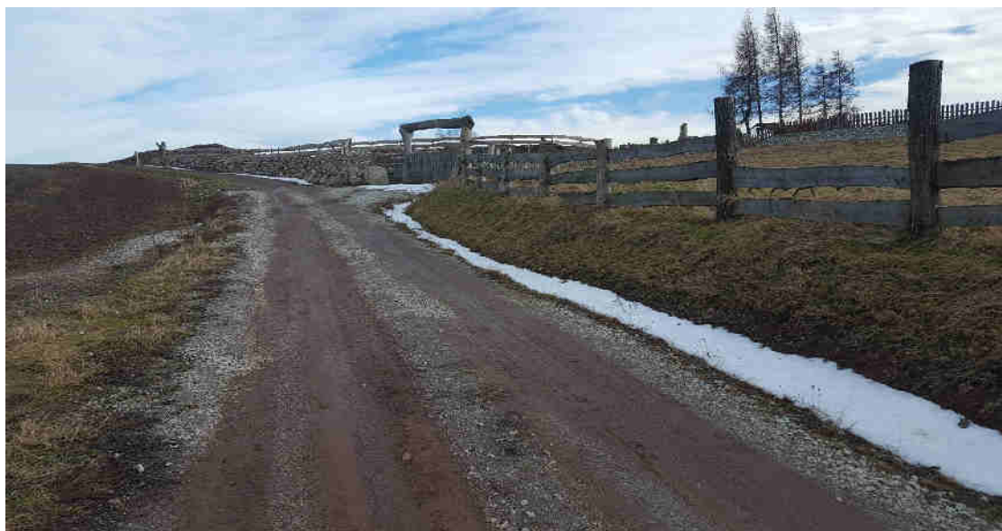
zdj. 1 Istniejąca droga w m. Gostków dz. 456 – rów prawostronny
