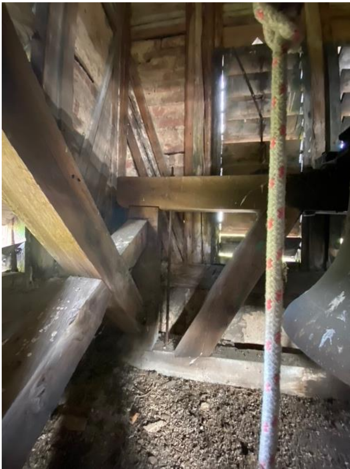
Fot. 7. Konstrukcja szachulcowa dzwonnicy oraz konstrukcja dzwonnicy z widocznymi żaluzjami drewnianymi.
