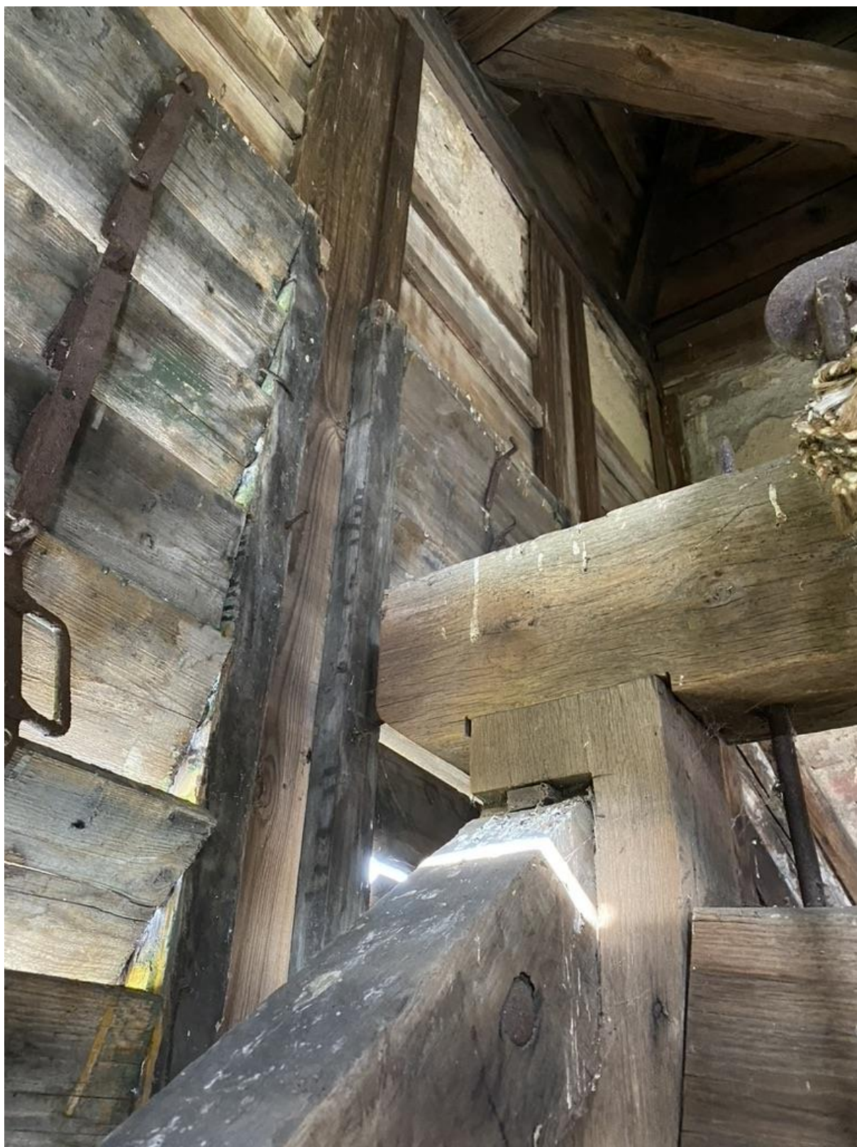
Fot.6. Konstrukcja dzwonnicy oraz żaluzje zewnętrzne
