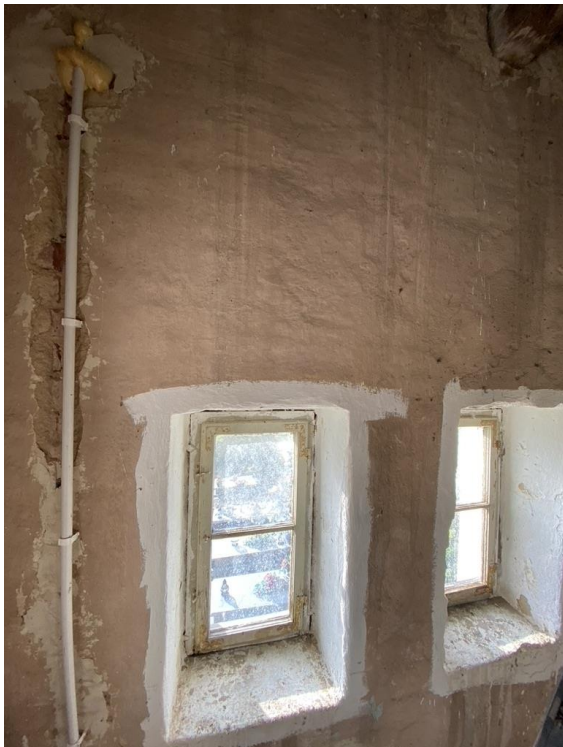
Fot. 3. Wnętrze wieży poziom +3.25
