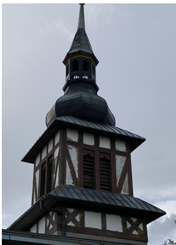
Fot. 1. Widok wieży (dzwonnica i hełm) od strony pn- zach.
