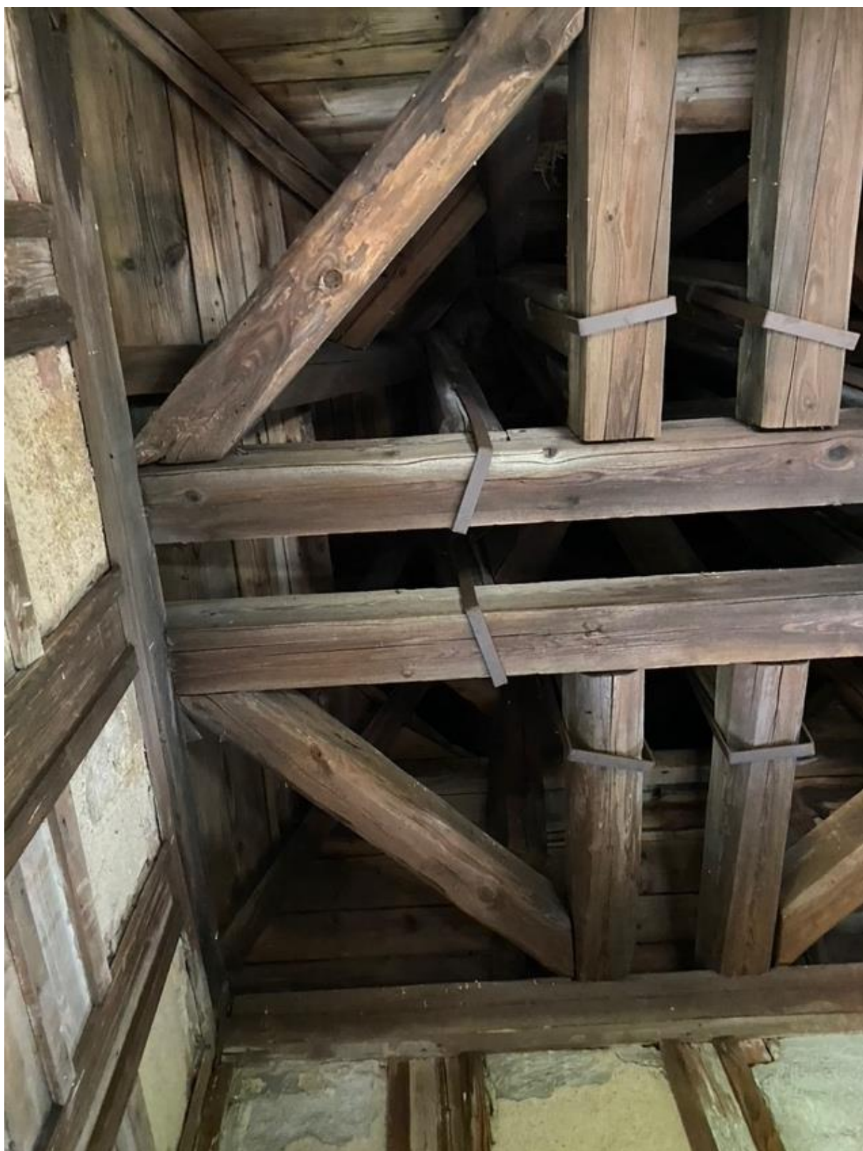
Fot. 7. Konstrukcja szachulcowa dzwonnicy oraz konstrukcja hełmu (od spodu)
