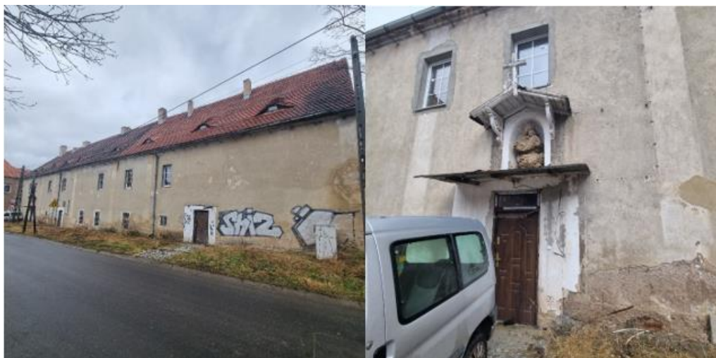
Fotografia 12. Widok na budynek dawnego klasztoru cysterskiego.
