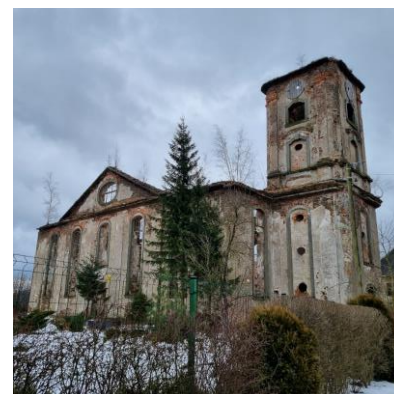
Fotografia 13. Widok na ruiny kościoła ewangelickiego w Gostkowie.
