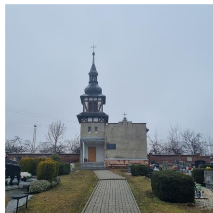
Fotografia 14. Widok na kaplicę cmentarną na cmentarzu w Cieszowie.
